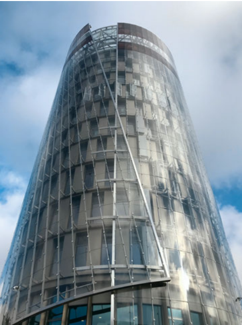
Science Tower in Graz by DI Markus Pernthaler Architekten
